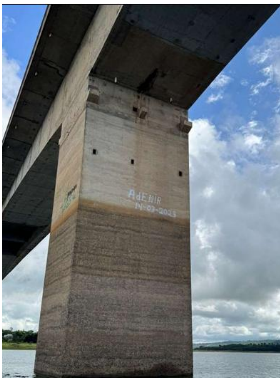
Foto 1 – Dano superficial aos pilares – Solução 1
