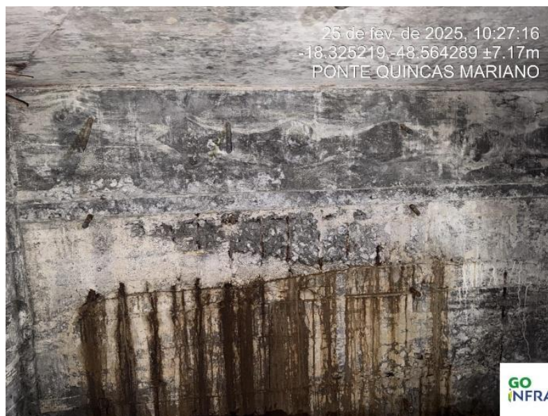
Foto 3 – Armadura exposta no balanço progressivo – Solução 3
